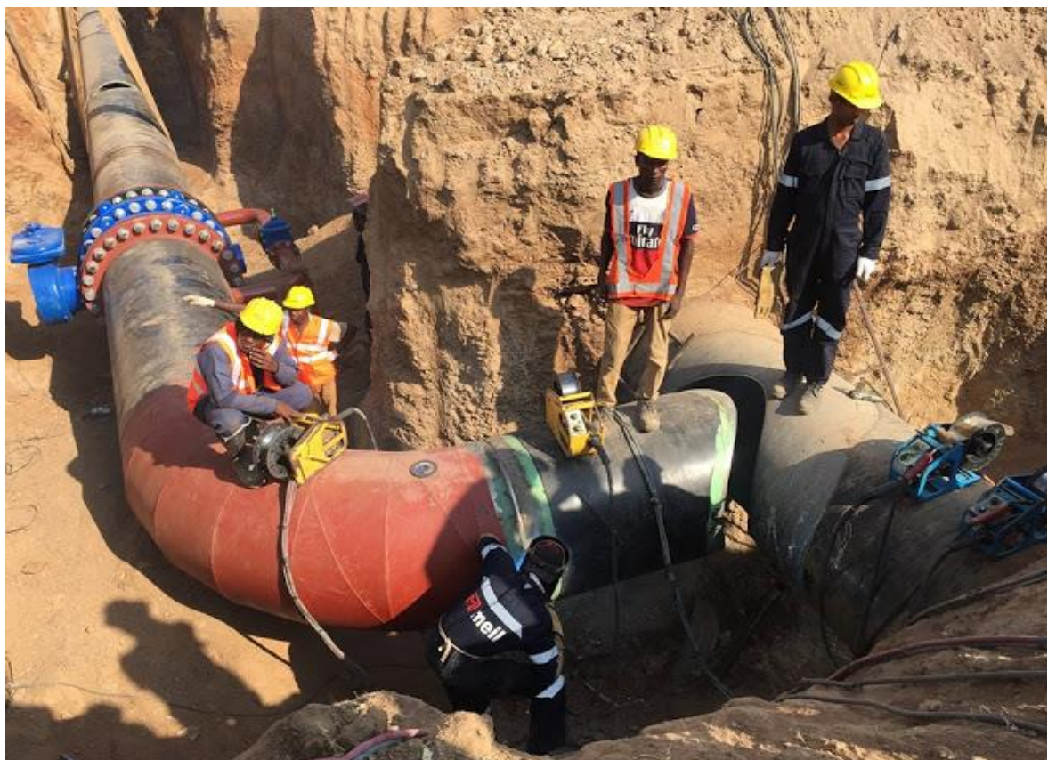
Ujenzi wa Bomba la Maji la kutoa maji Ziwa Victoria kupeleka katika Miji ya Tabora, Nzega na Igunga na Vijiji zaidi ya 120 ukiendelea katika eneo la Solwa.
